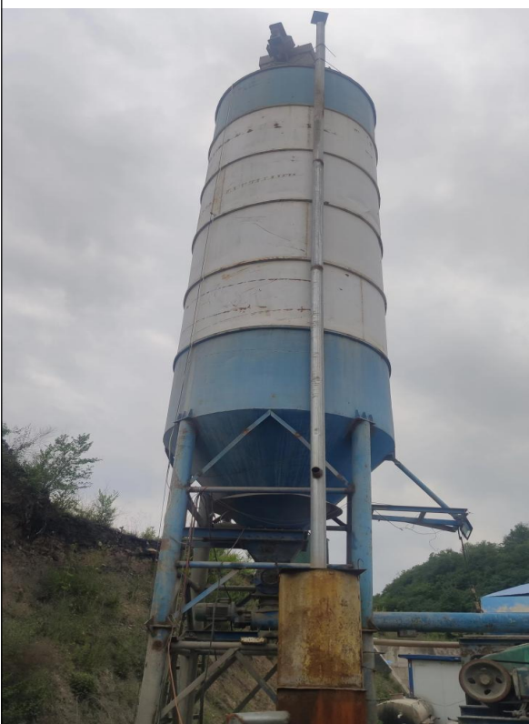
15m 高排气筒
