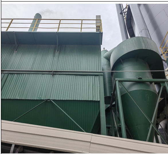
石灰窑烟气旋风初尘+布袋除尘+脱硫塔+30m 高排气筒
