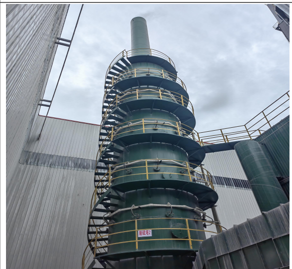
石灰窑烟气旋风初尘+布袋除尘+脱硫塔+30m 高排气筒
