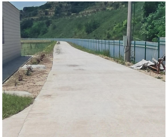
厂区便道硬化
