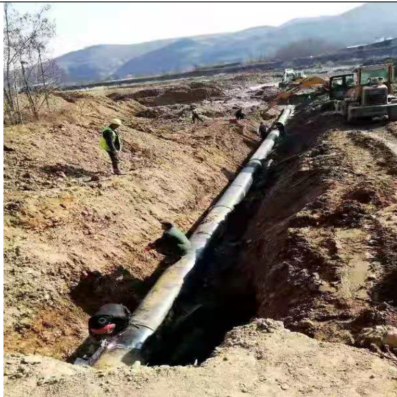
施工期管道敷设
