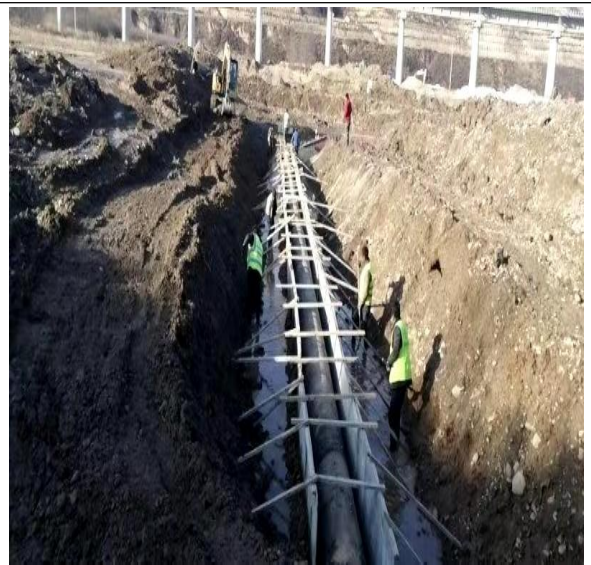
施工期管道敷设
