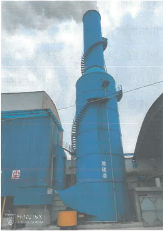
脱硫塔及排气筒
