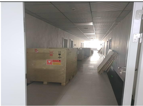
至验收阶段的设备拆箱、安装
