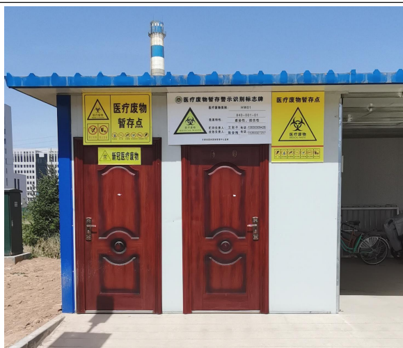
医疗废物暂存间
