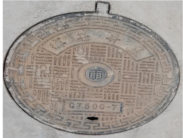
雨水管网检查井
