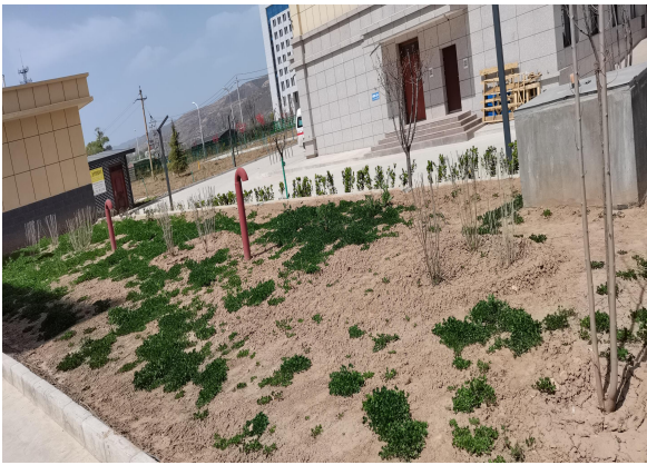
地埋式消防水池 (350m 3 )
