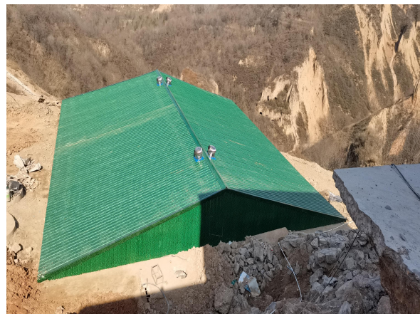
渗滤液调节池封顶
