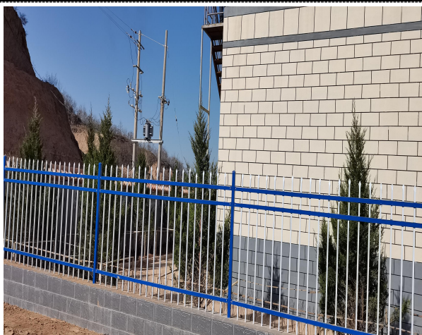
渗滤液处理站围栏
