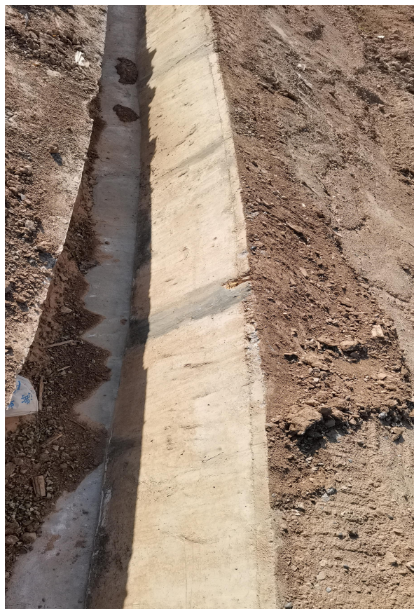
库区旁排水渠
