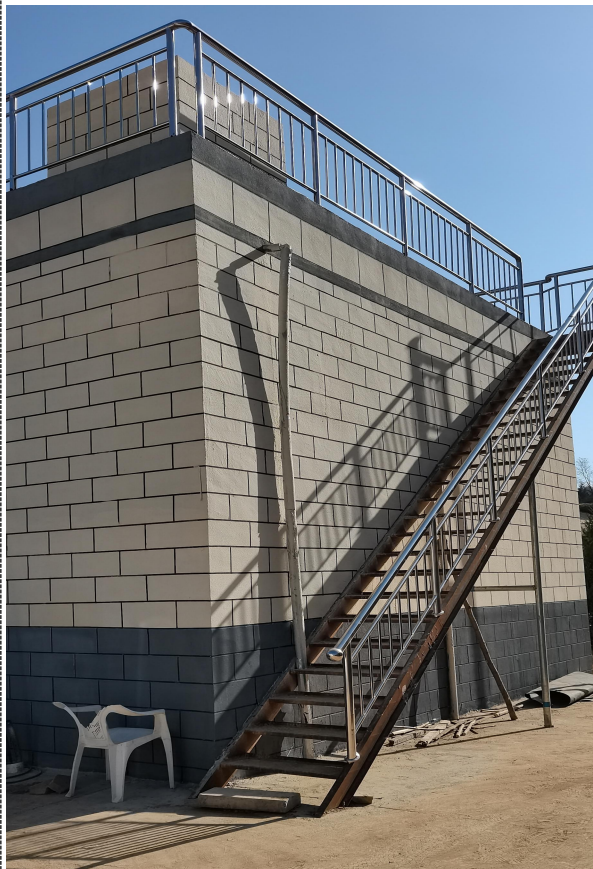
渗滤液处理站综合水池
