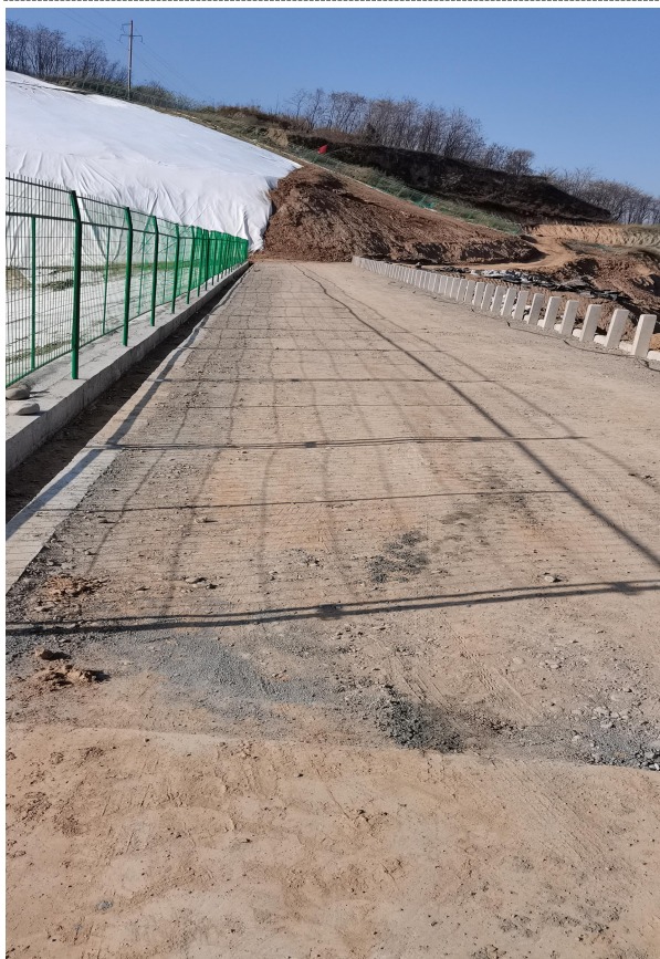
填埋区道路硬化
