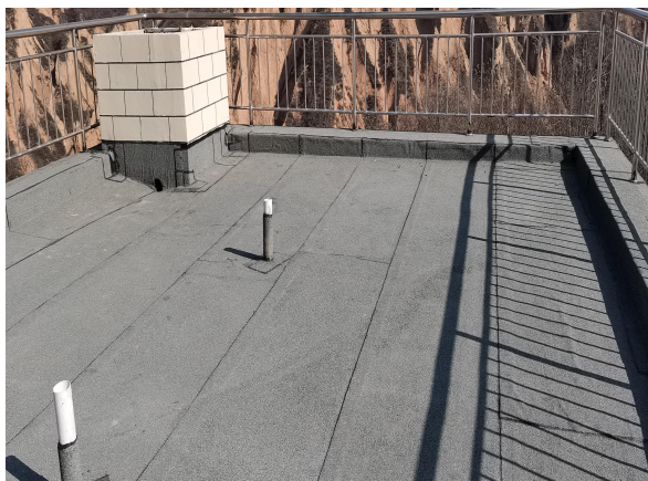
渗滤液处理站综合水池封顶
