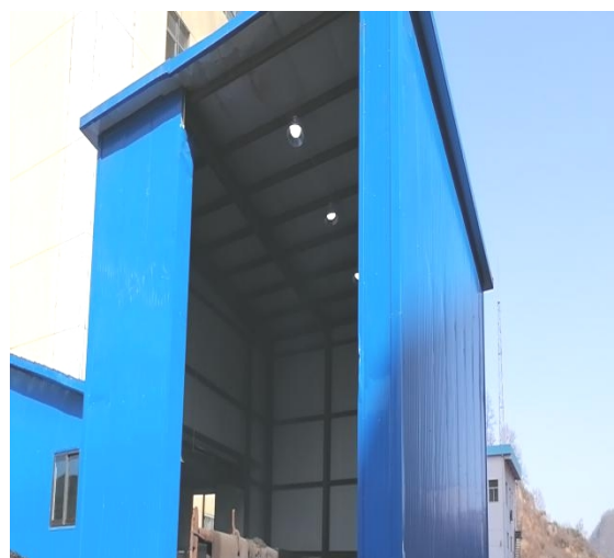
半封闭式储渣库
