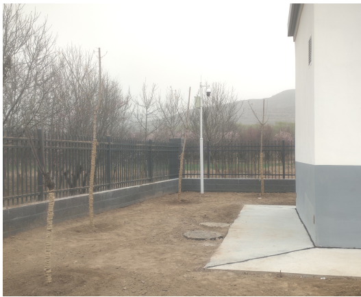
污水处理厂原水进水井
