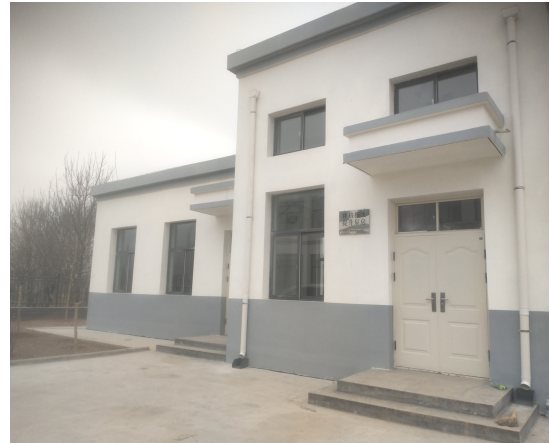
粗格栅间及提升泵房
