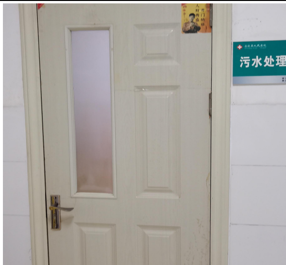
封闭式污水处理加药间
