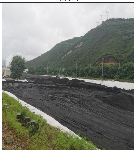
摊平压实的作业面及边坡绿化
