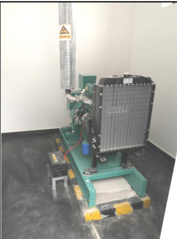
发电机减震基座
