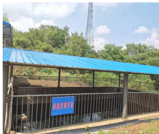
渗滤液收集池
