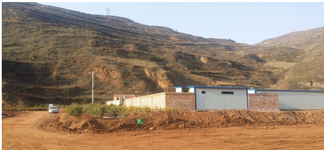
2016 年开挖面和工区外绿化
