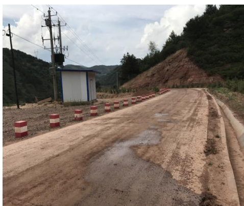
2017 年道路排水沟照片
