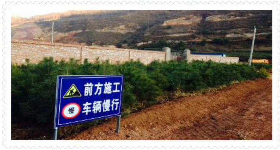
施工场地围墙外绿化措施
