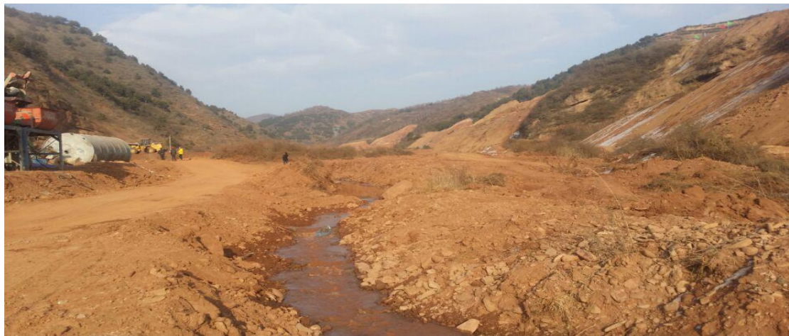
库区内临时排水措施
