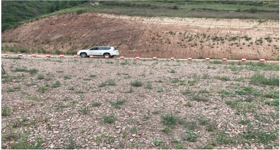
2017 年库区砾石覆盖
