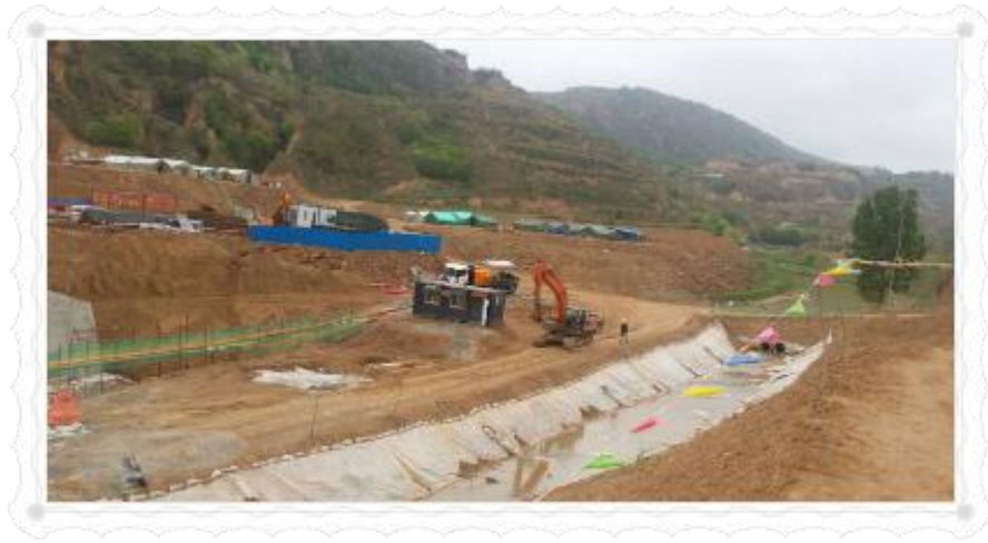
2016 年排水工程建设
