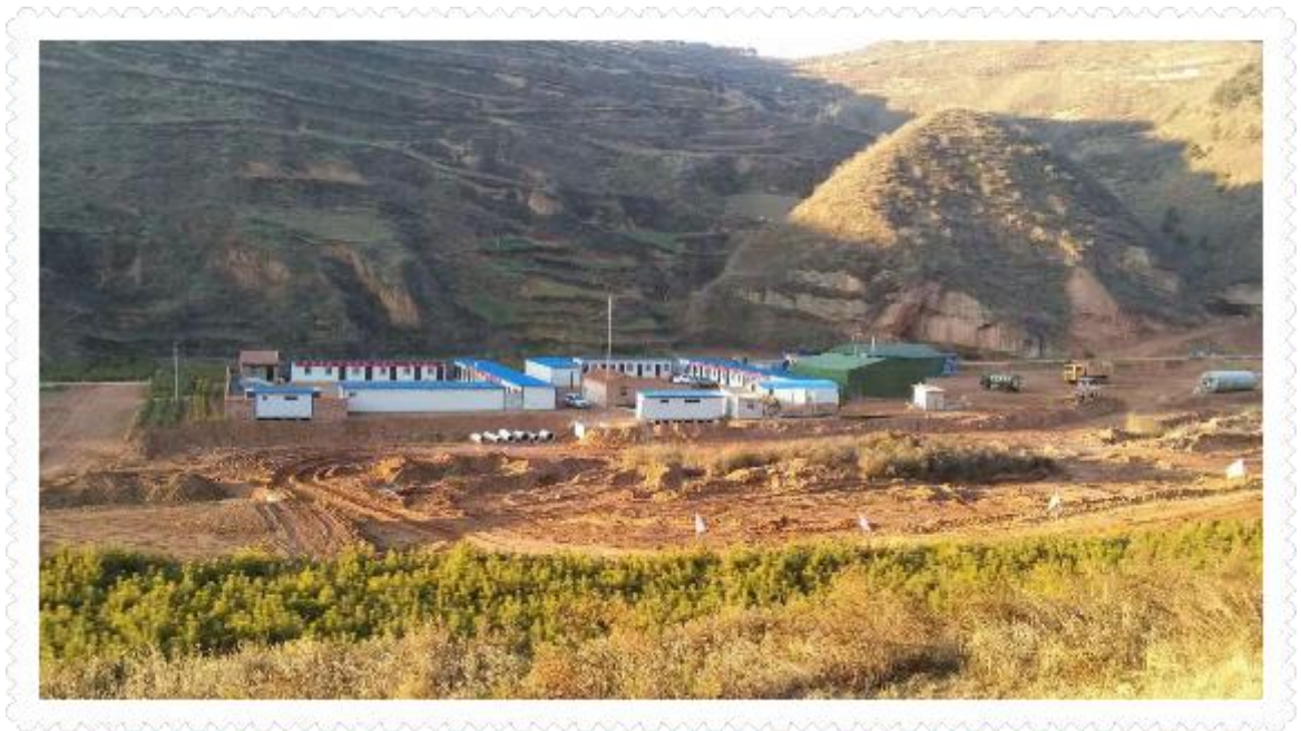
2015年11月施工单位驻地及库区
