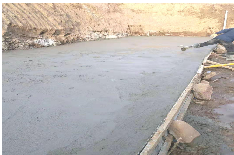
池体地基采用钢筋混凝土
