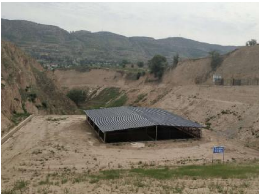
渗滤液收集池（兼消防水池）
