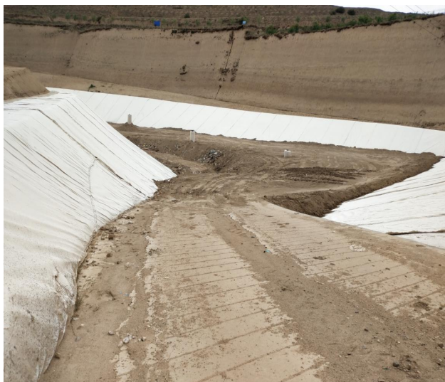
土工膜防渗系统
