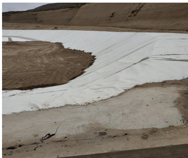
土工膜防渗系统
