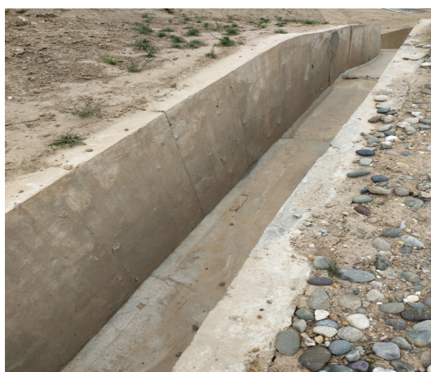
填埋场两侧截洪沟
