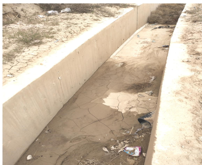
填埋场两侧截洪沟
