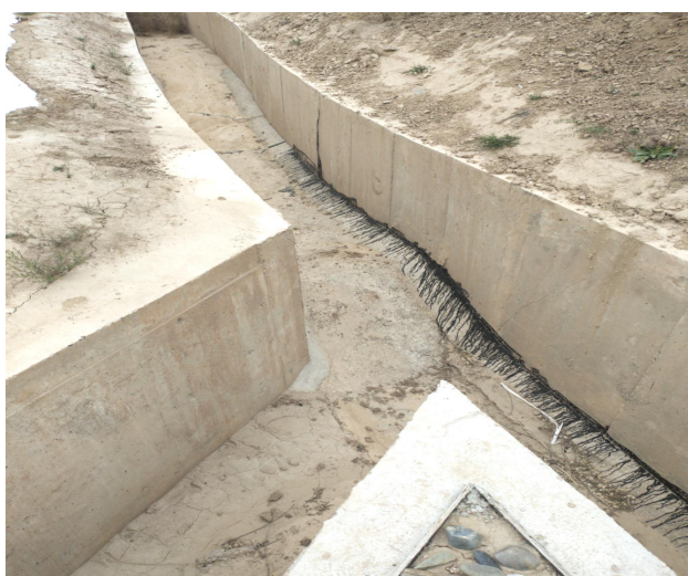
填埋场库区内截洪沟
