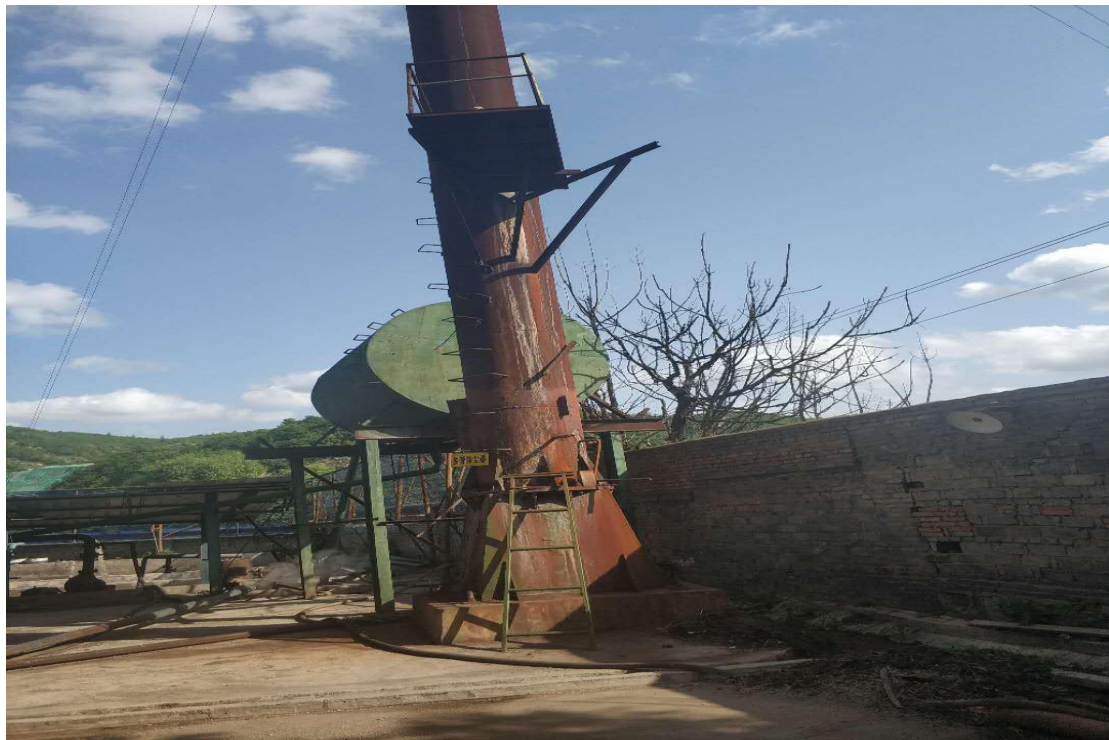
图 3-2 加热炉废气排气筒
