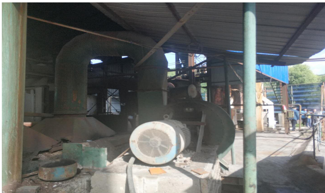
图 3-1 多管除尘器
