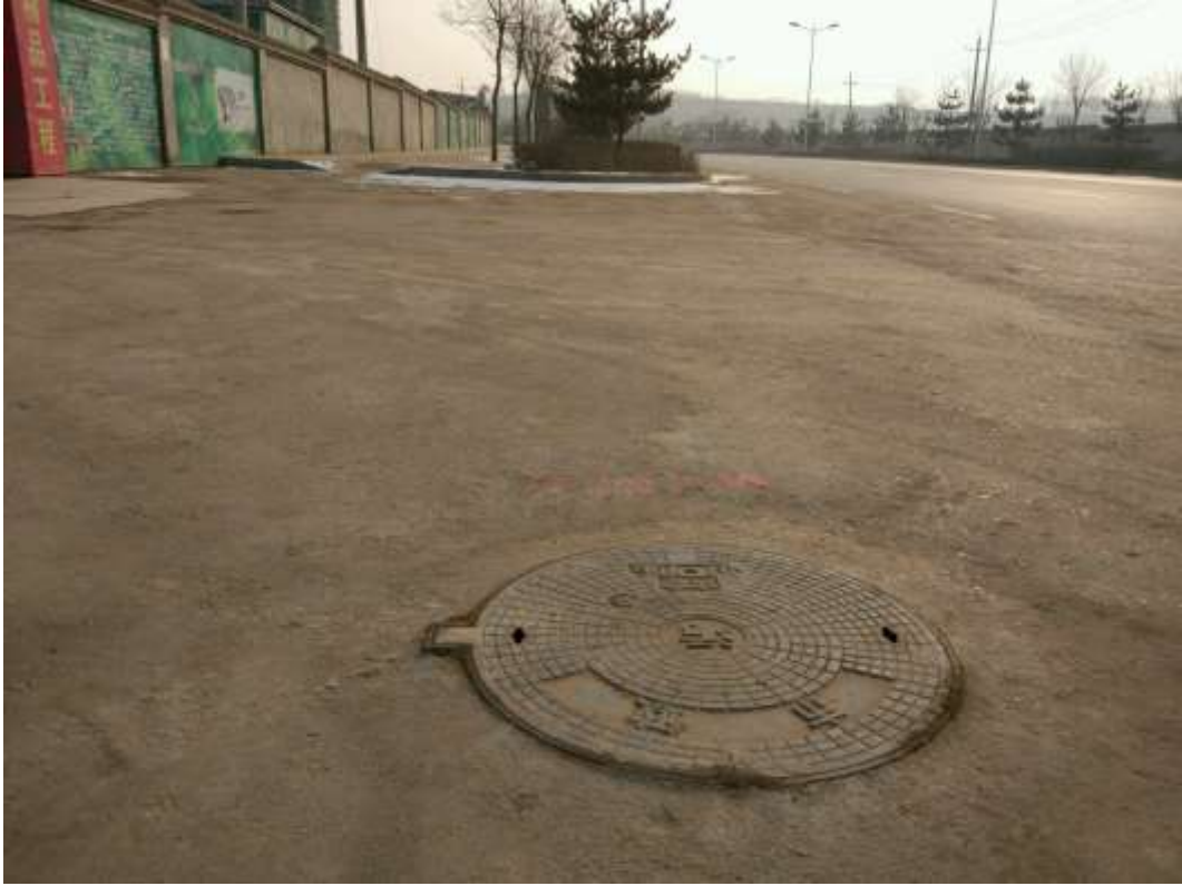
鸭儿沟（水泥厂家属院至红卫桥）
