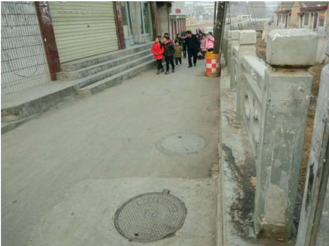
水桥沟（东西大街至柳湖路）
