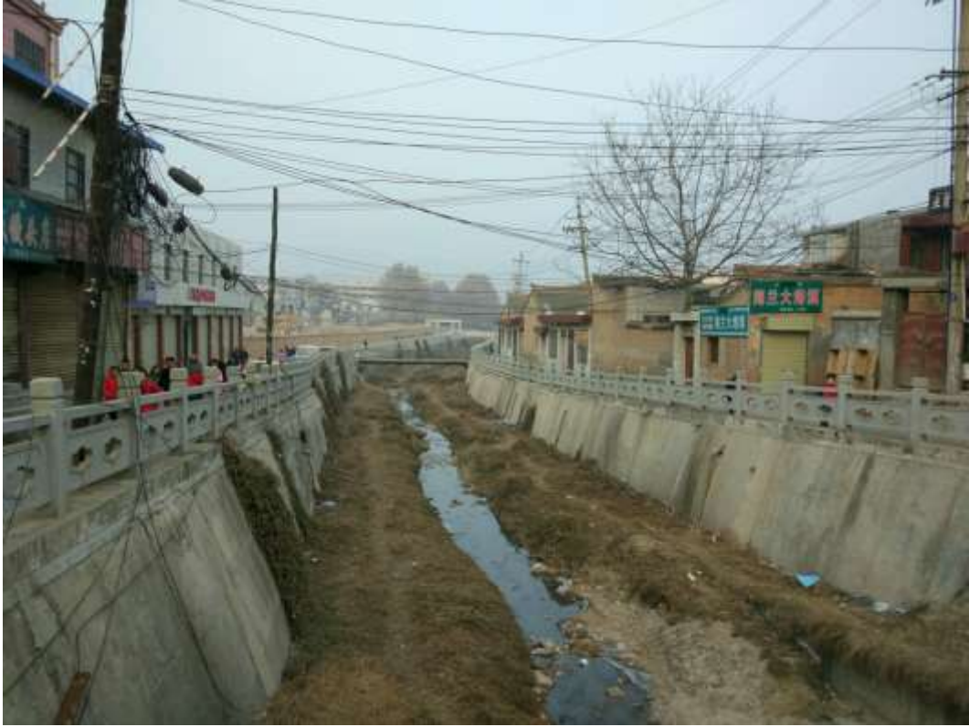
水桥沟（东西大街至柳湖路）
