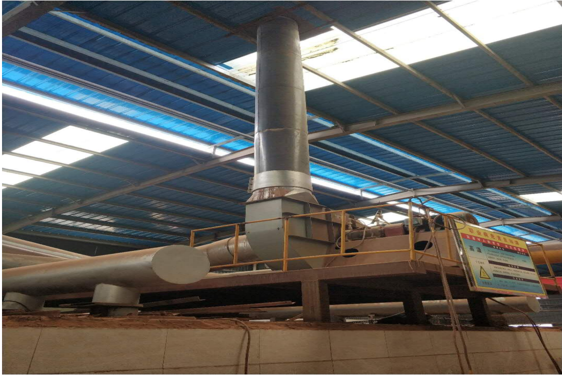
图 3-4 梭式窑排气筒
