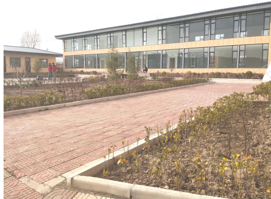
厂区绿化及办公区
