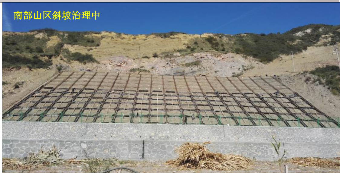
南部山区斜坡治理后
