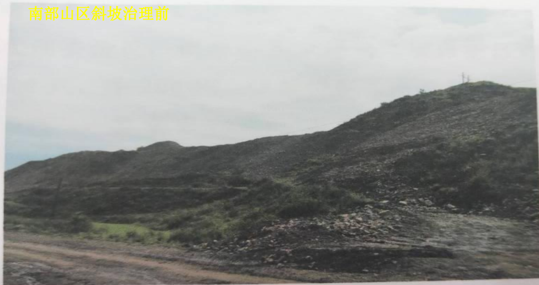
南部山区斜坡治理中
