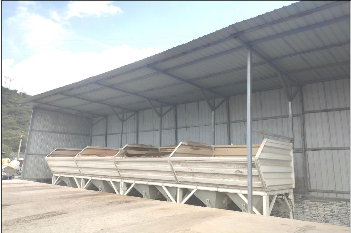
物料混合区半封闭的挡风墙
