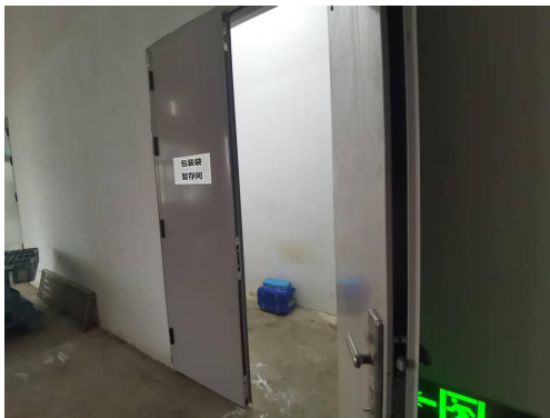
一般固废暂存间
