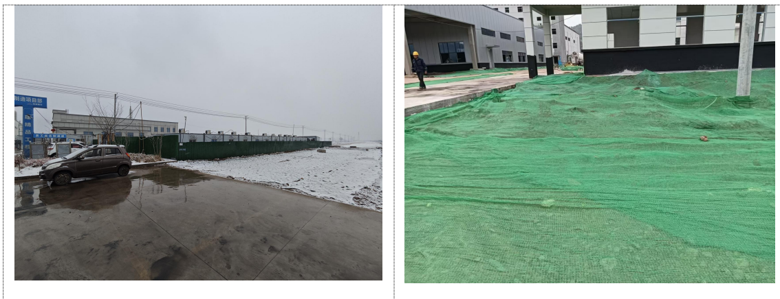
图 4-1 施工期抑尘措施现场图
