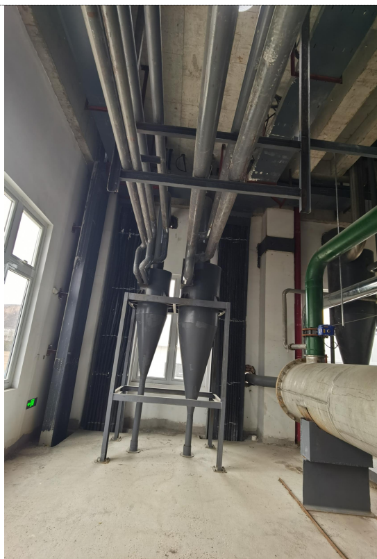
发酵罐排气管道
