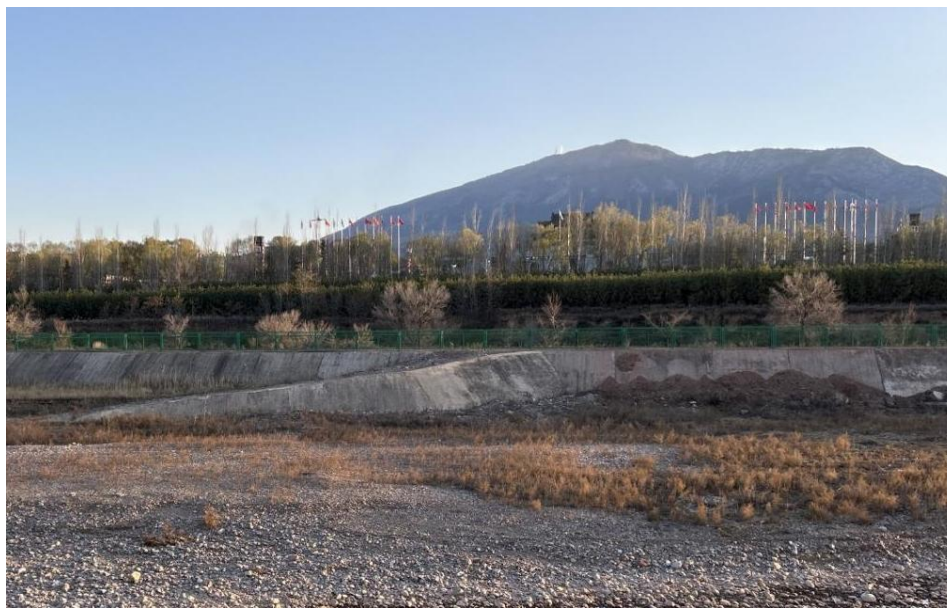
图 3.4-4 现状右岸下河坡道
