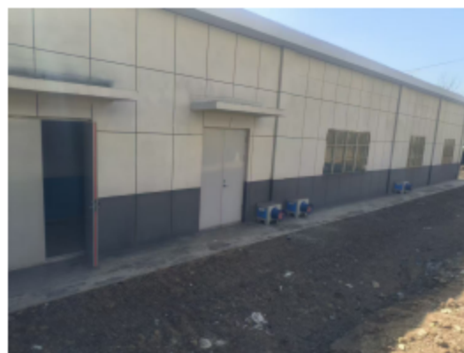
厂房整体图（朝北）
