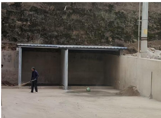
一般工业固体废物存储间
