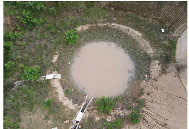
初期雨水沉淀池
