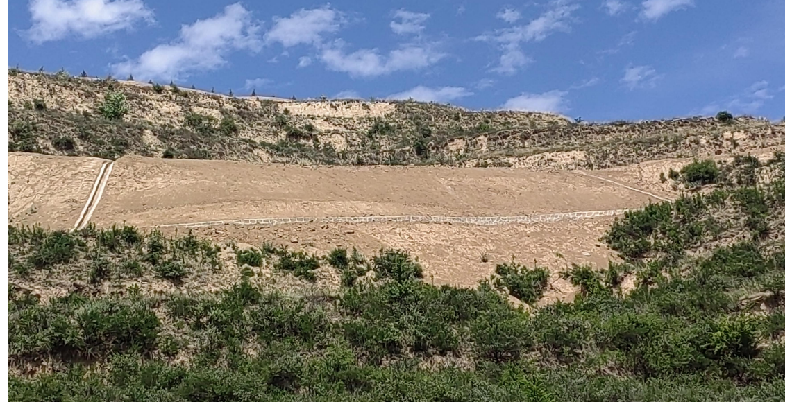
拓宽道路挡土墙及排水沟
