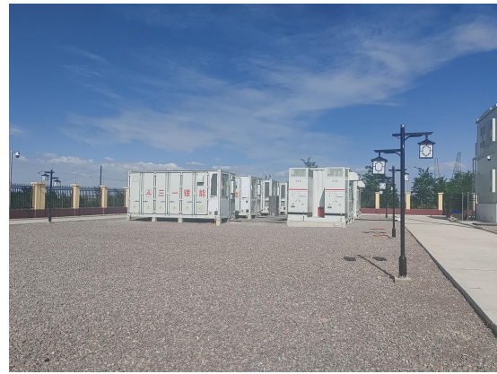
升压站厂区铺设石子
