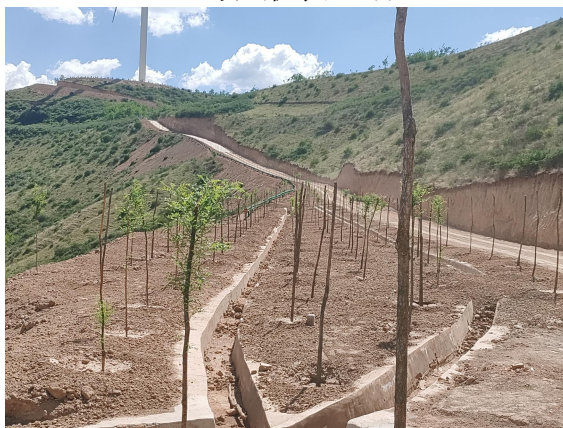
排水沟渠及临时道路
