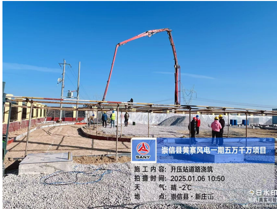
升压站厂区道路硬化
