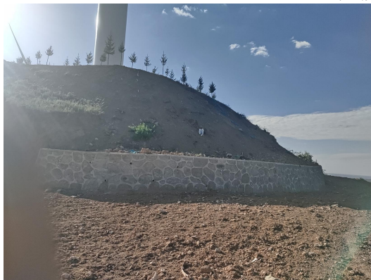
2 号风机挡土墙
