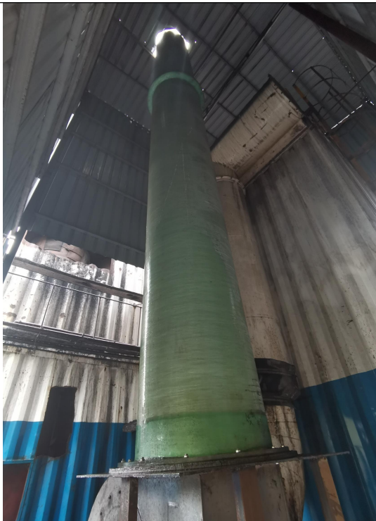
20m 高排气筒
