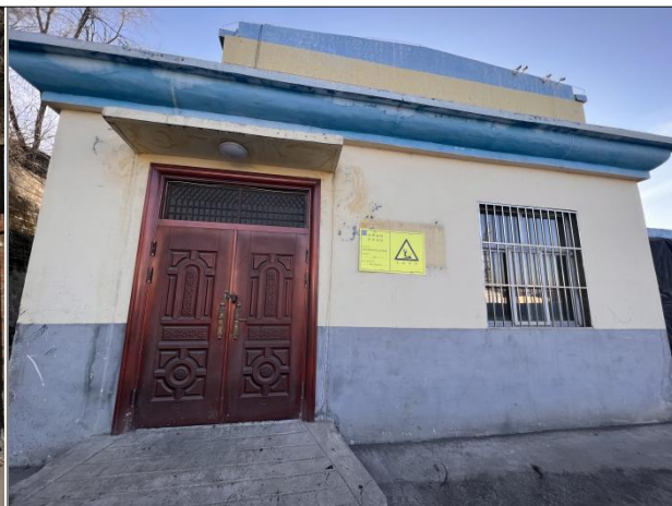
废矿物油间及危废标识牌
