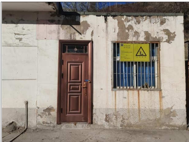
分析残液间及危废标识牌
