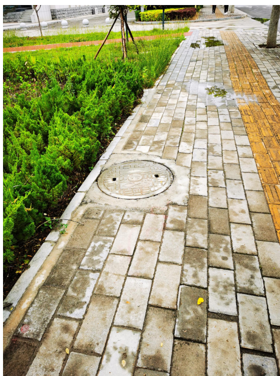
化粪池出水检查井
