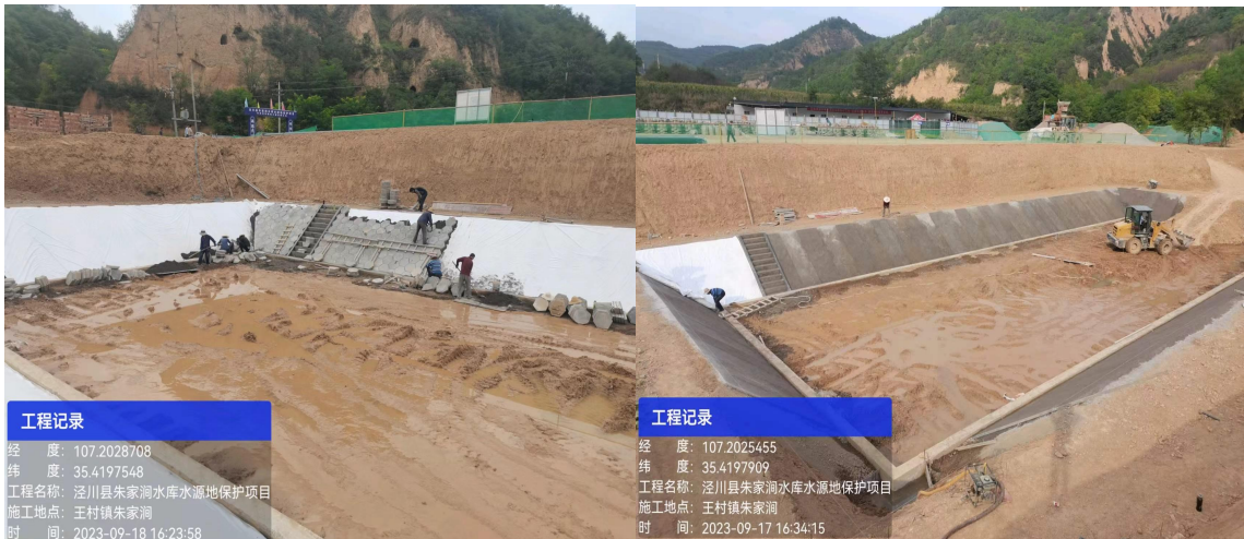
沉砂池施工照片
