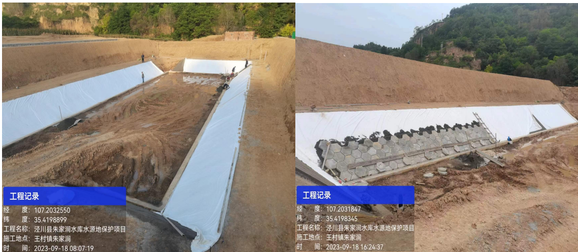
沉砂池施工照片
