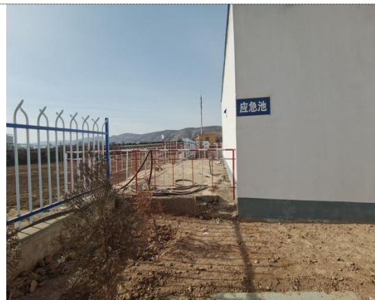
事故应急池及清水池
