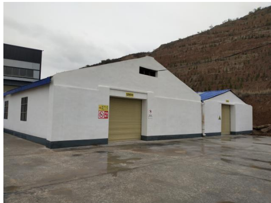
危废暂存间外貌
