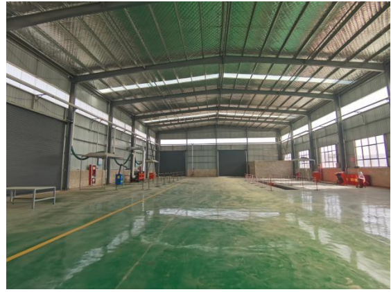
拆解车间内部
