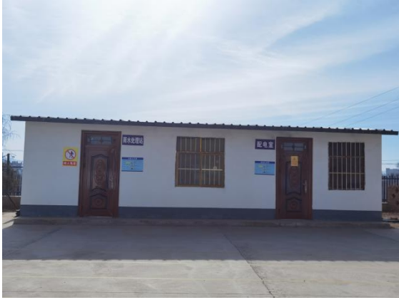
初期雨水处理车间
