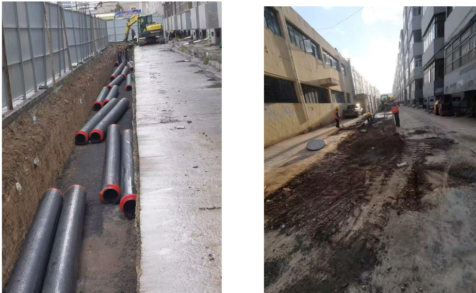
图 5-1 一级供热管网敷设现场图
