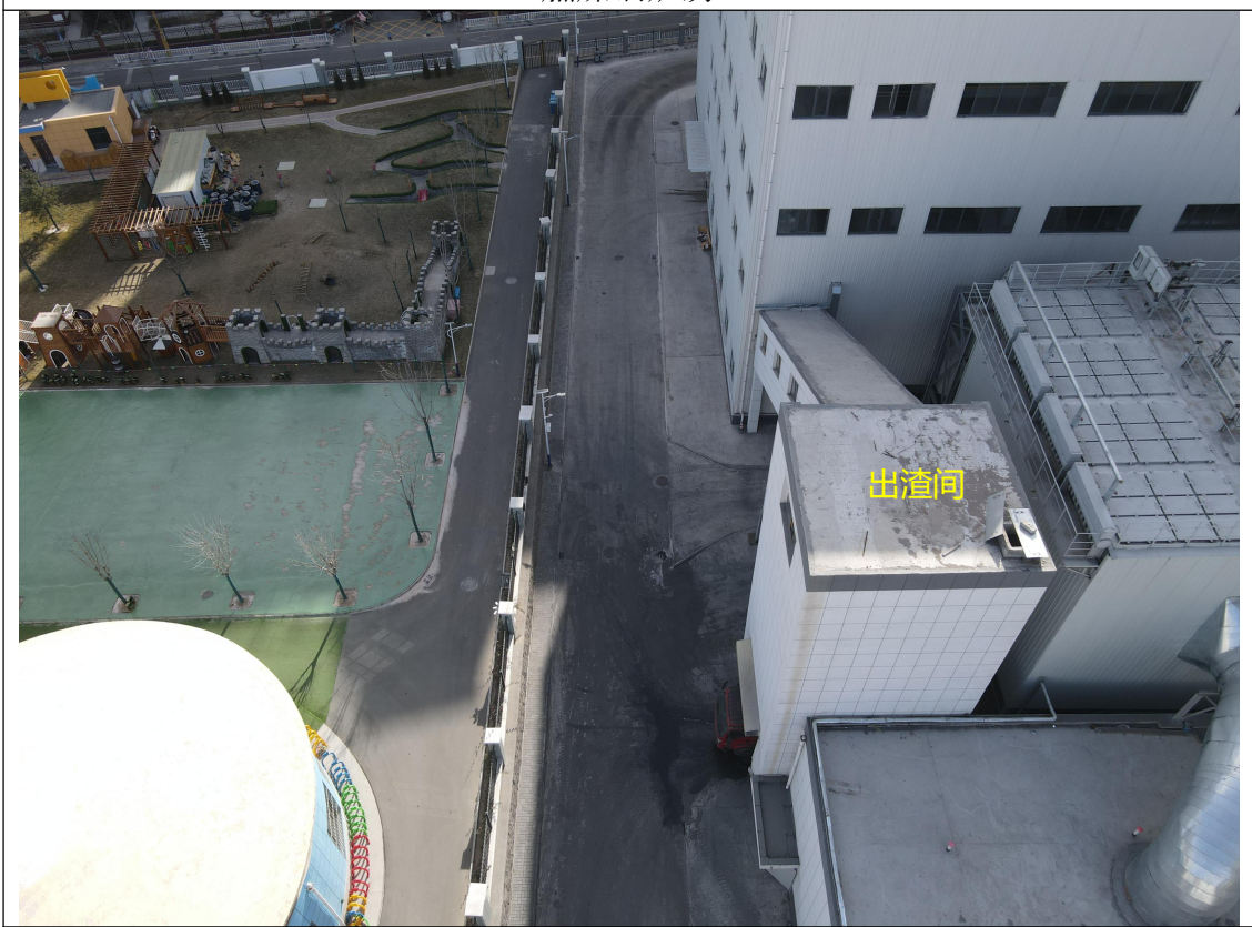
出渣间（储渣间）
